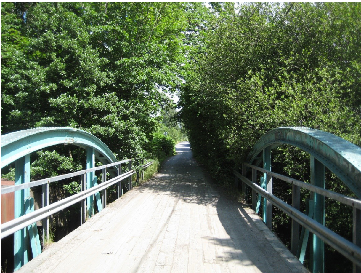
Figur 2.4-2. Befintlig bro över Lärjeån. Foto: Sweco, 2020.
